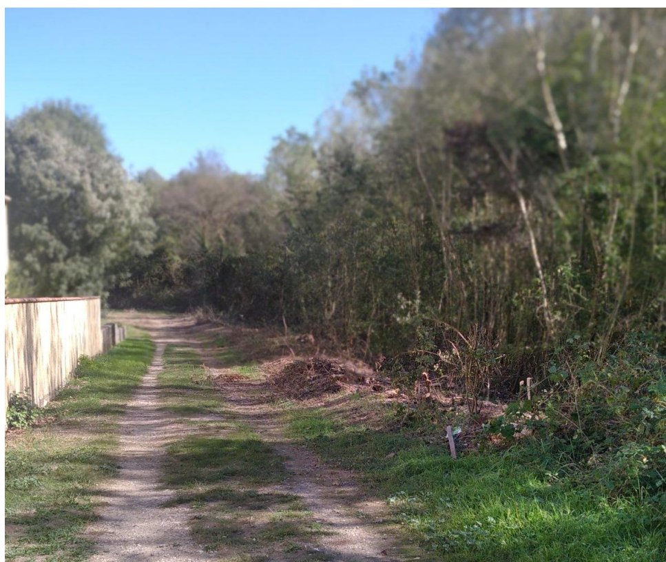
Emplacement de la future digue
