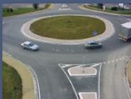
la CCLG a assuré la réalisation des abords du rond-point dans le cadre d'une co-maîtrise d'ouvrage avec FEnas.
