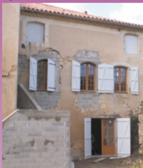
Logement à Cézan
